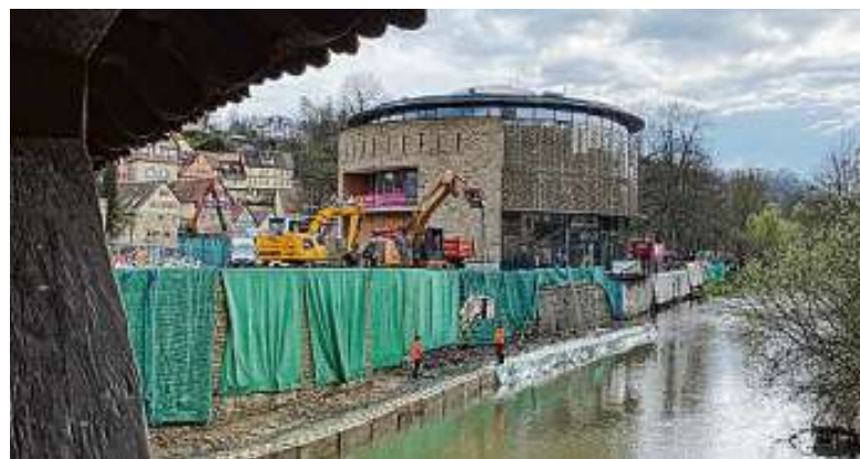
Die Bauarbeiter spielen wieder Lego. So sieht es zumindest aus: Riesige, mit Noppen bestückte Betonsteine werden im Kocher zu einer Mauer aufgeschichtet. Die Sanierung der Mauern vor dem Globe Theater startet. Foto: Tobias Würth
